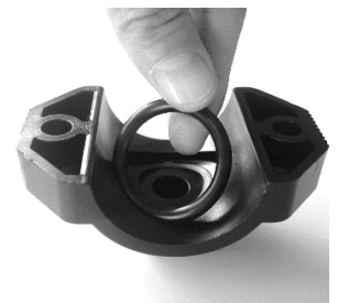
Figure 18 : Pose du joint torique sur le collier de prise en charges.
